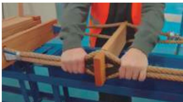
Fig. 12: Pasos para la introducción de un peldaño de sustitución.
