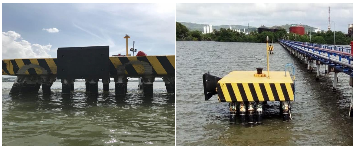
Figura 4. Características de las piñas de atraque y amarre en el sector oriental de la de DEXTON S. A.
