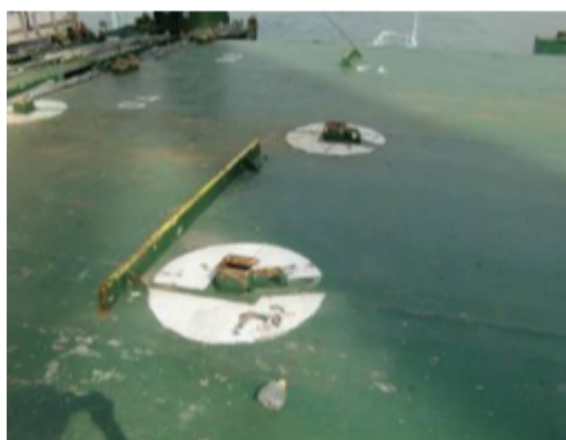
Ilustración 21 Verificación cantoneras para izaje de las tapas
